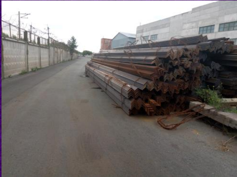
Нарушение порядка складирования
