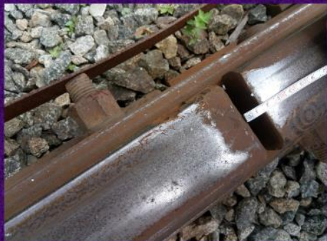
Превышение зазора в стыках рельсового пути
