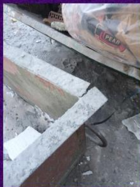
Использование неисправной тары
